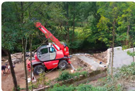
Construction «sauvage» d'une micro-centrale sur la Desges © SOSLV - ERN France
