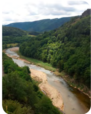
L'Allier retrouve temporairement son ancien lit, sur la partie amont de la retenue
