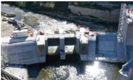
Le «Nouveau Poutès» en septembre 2021, vannes levées ! © SOS LV
