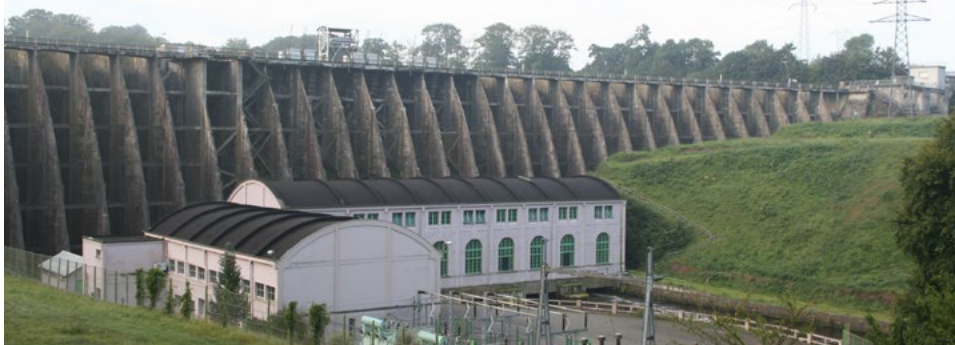
Barrage de Vezins sur la Sélune (36 m) - © J-P Doron
