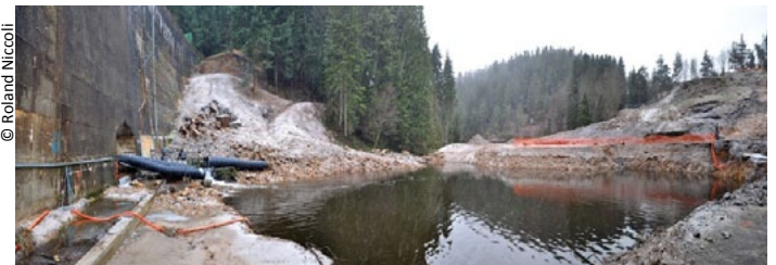
Les travaux du non-sens ont repris sur le barrage des Plats après une courte interruption hivernale
